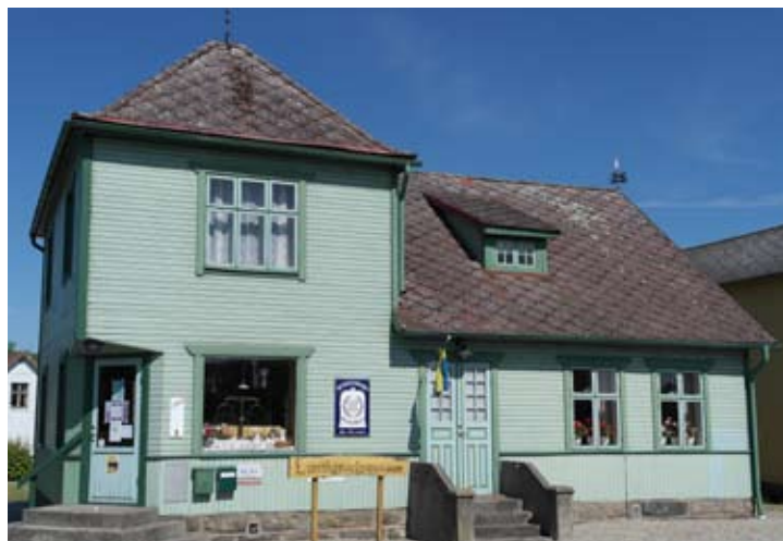
Lanthandelsmuseet i Önnköping. Under 2013 påbörjades renovering och ommålning av fasaden
